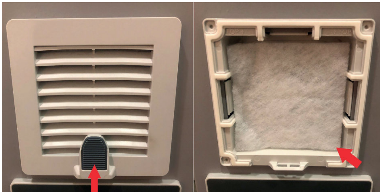
Рисунок 4.3-1 Замена воздушного фильтра
